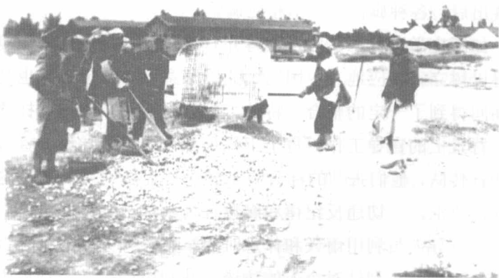
（民工在修建机场副跑道）
