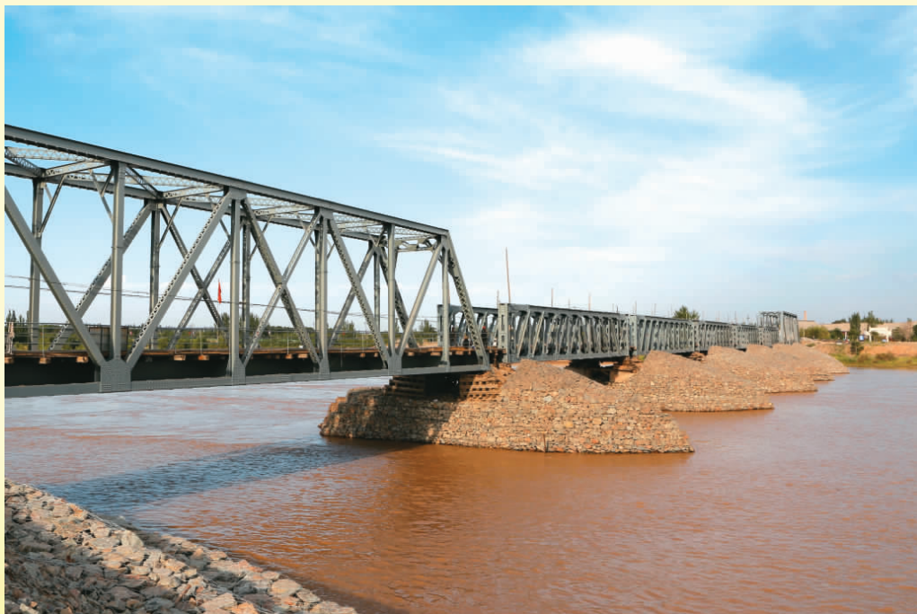
修缮加固后的青铜峡黄河铁桥
