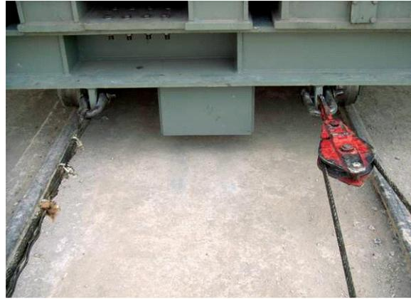
图 1-10 换流变压器牵引就位
