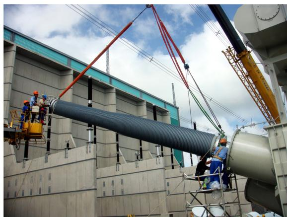
图 1-7 阀侧套管安装
