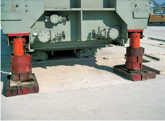
图 1-9 换流变压器顶升
