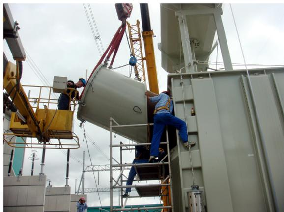
图 1-5 阀侧升高座安装
