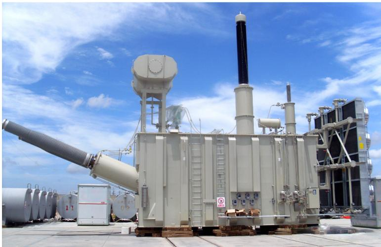
图 1-11 换流变压器整体安装效果
