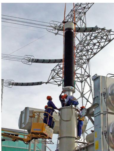
图 1-6 网侧套管安装
