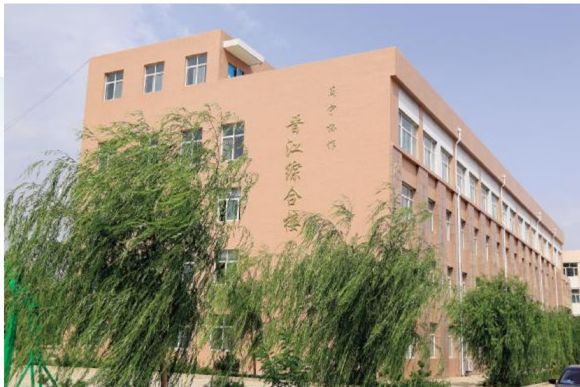
红寺堡区人民医院晋江综合楼
