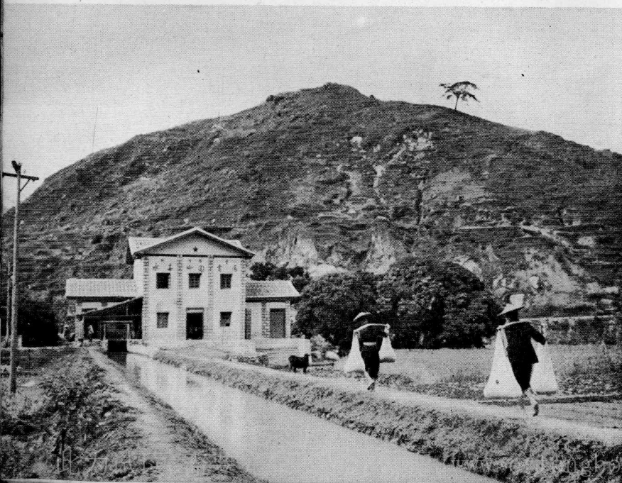
卿园水电站，是永春县目前最大的一个水电站，安装有64匹马力木质水轮机一台。
