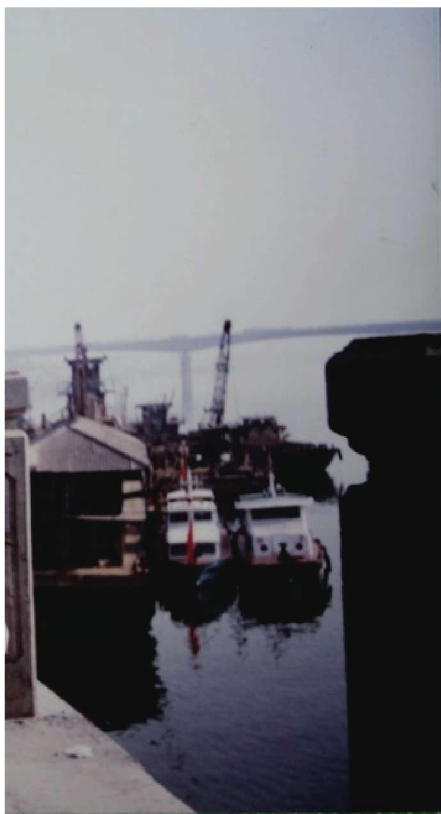
◎ 常德沅江大桥
