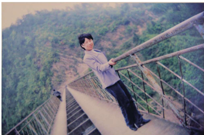
◎安化县东坪镇木子乡的引水渠桥
