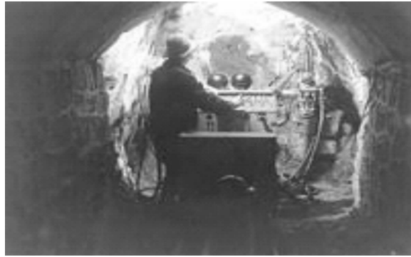
图2 坑探石门(平巷)实景图
