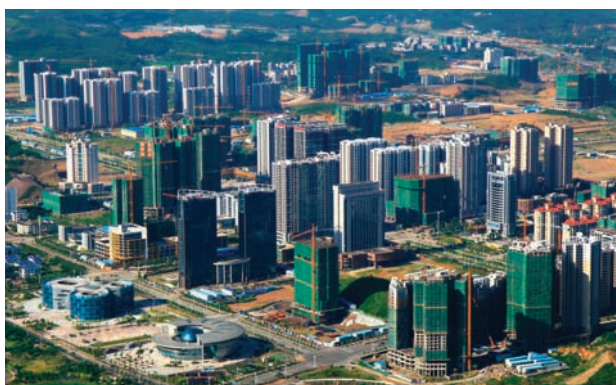
建设中的商务中心区
