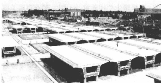
图 1.2.1—1 移梁台车移梁的制梁场布置
