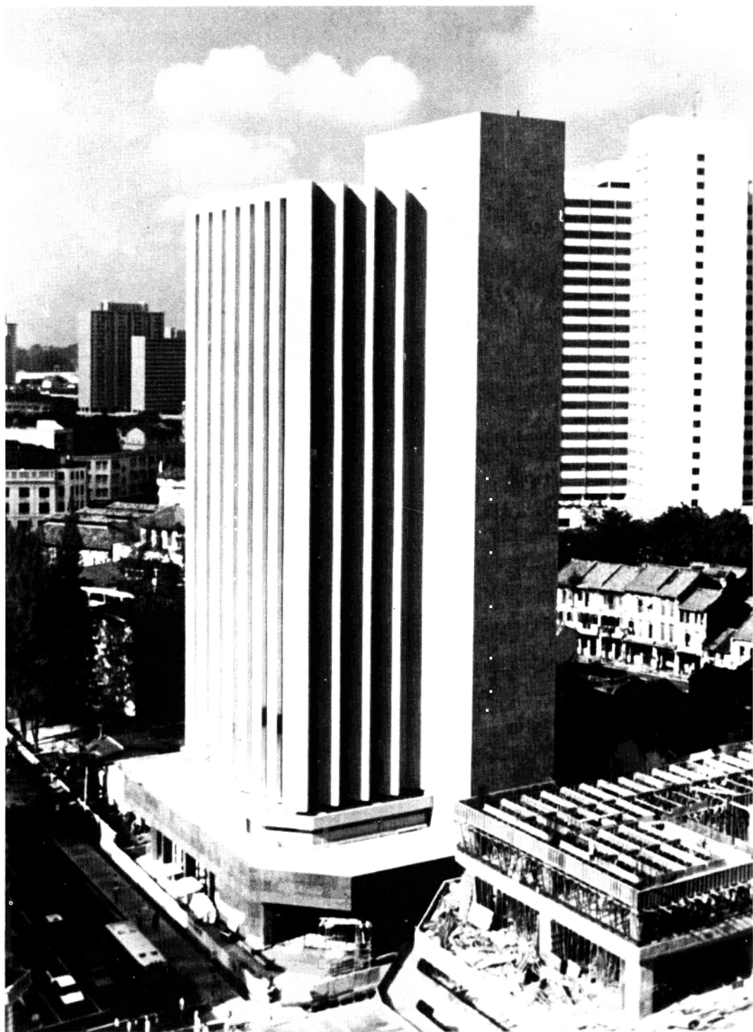
盤谷銀行在世界各大都市均設有分行，此係新加坡分行大廈外貌。
