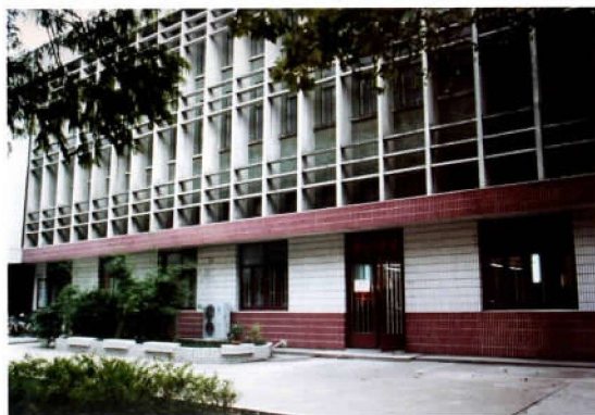
图7 1983年建成的本馆古籍藏书楼——“静海楼”
