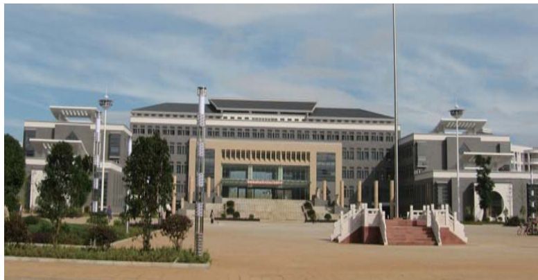
云南省中医学院五色广场和科技信息中心大楼
