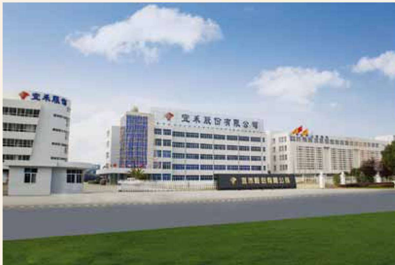
宜禾股份有限公司扬中基地。
