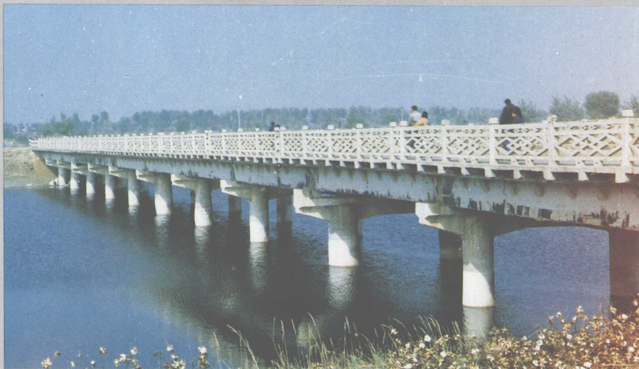
滏东排河邢家庄公路桥
