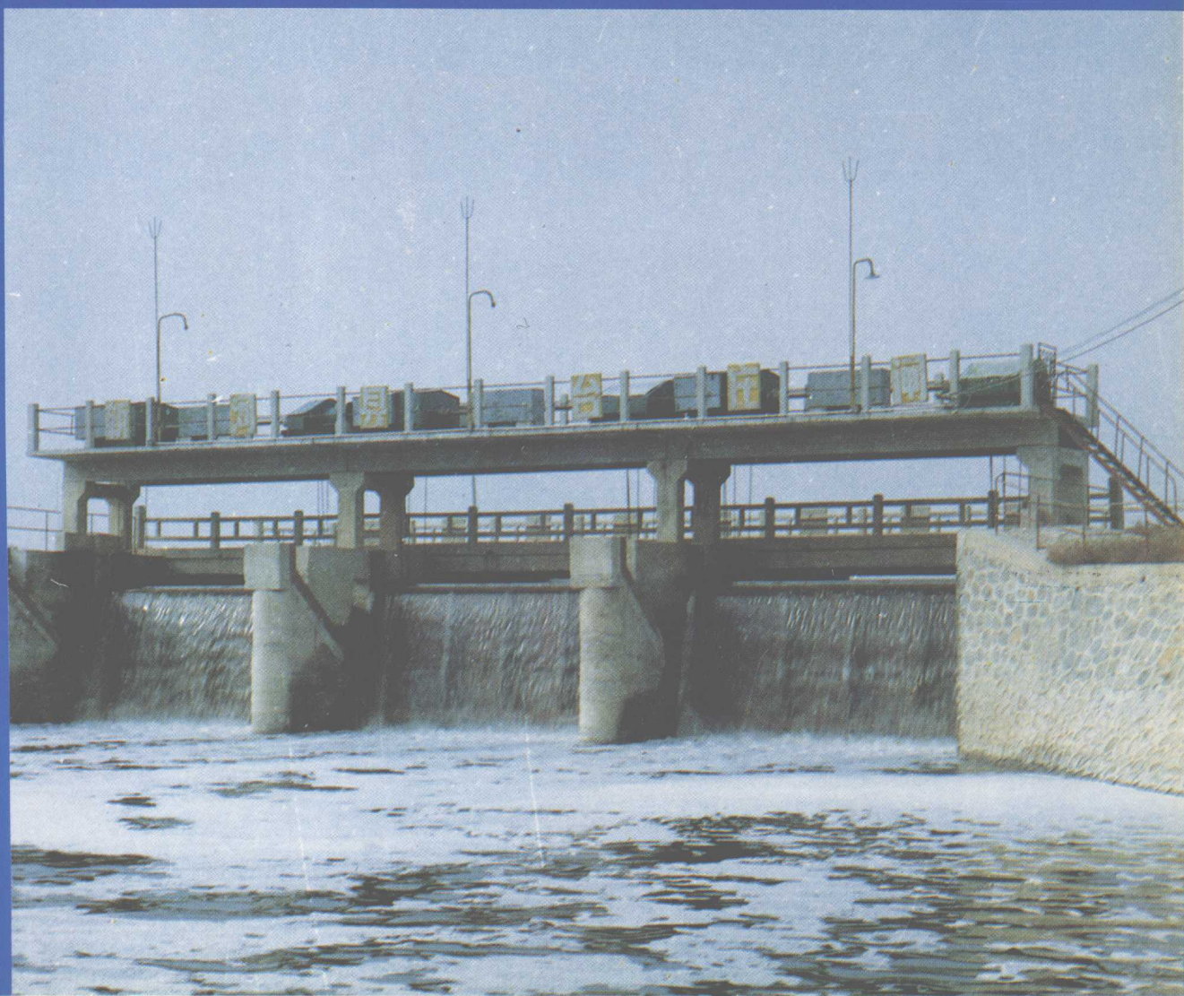
西沙河台家庄节制闸
