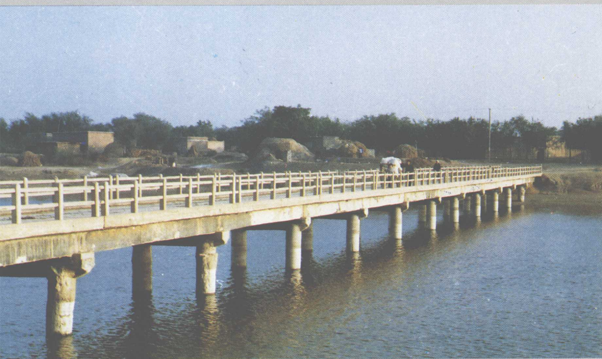
溢东排河挽庄拖拉机桥
