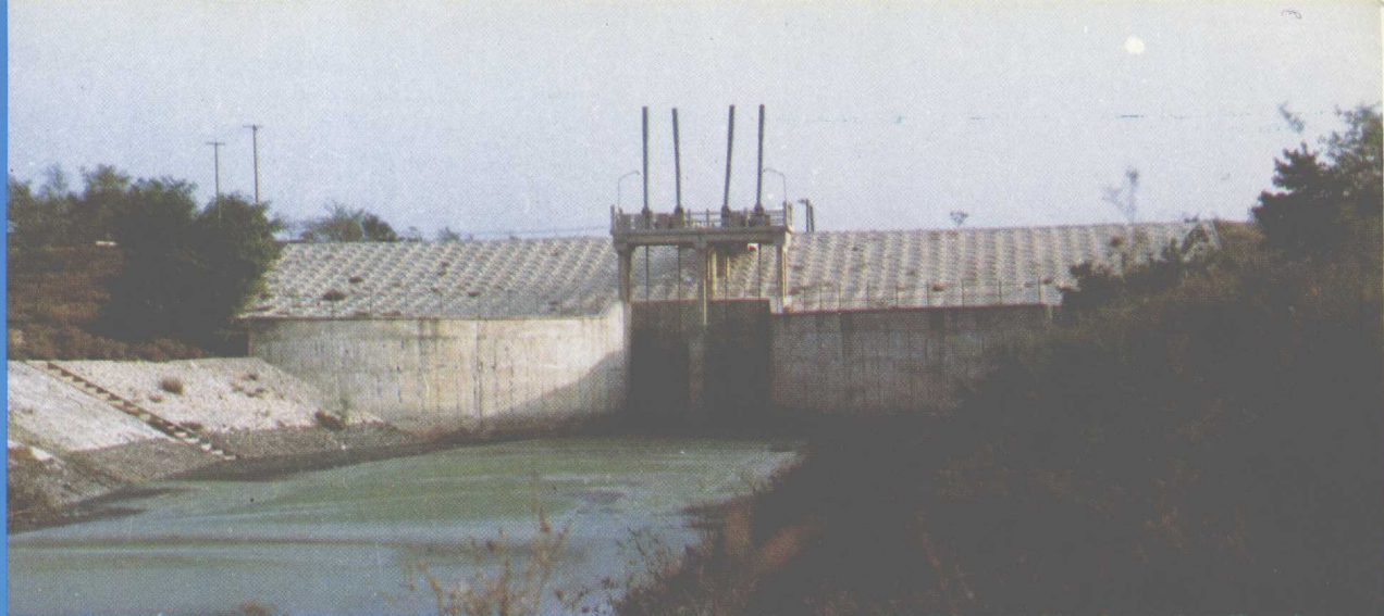
北陈海穿堤涵洞
