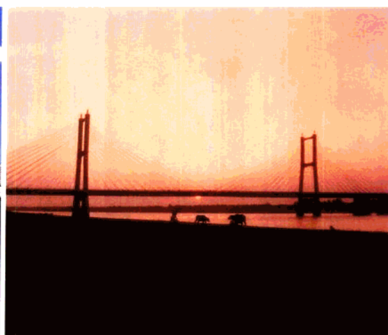
凤台淮河公路大桥
