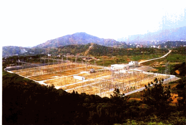
奇田 500 千伏变电站
