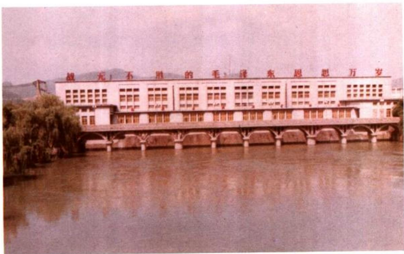
▲ 阳新县变害为利在富池修建灭螺排灌闸（1968年）
