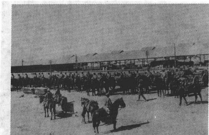
不抵抗政策使日本侵略者更加肆无忌惮。图为日本骑兵正在沈阳车站集结，侵略的魔爪从这里向整个东北伸去。
