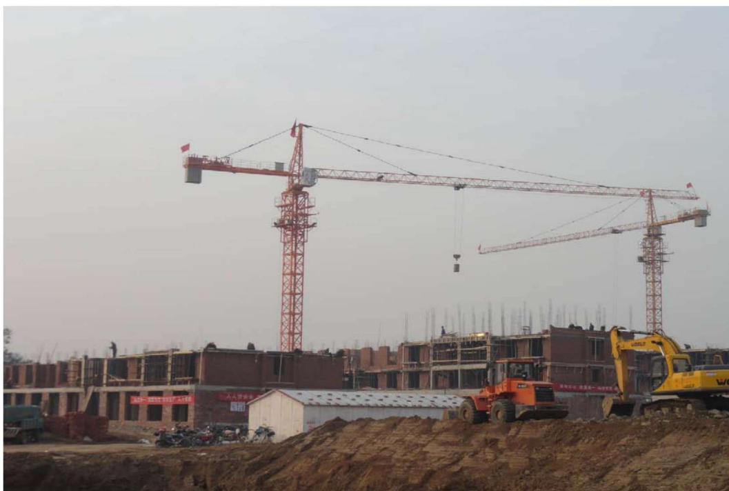
建设中的“翰林官邸”小区
