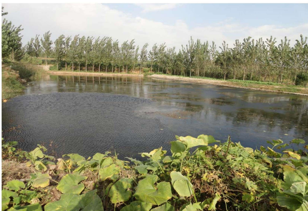
改扩建后的蓄水池
