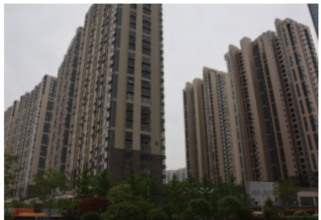
2014年，市南区燕儿岛路改造项目一期安置房竣工交付，居民顺利回迁
