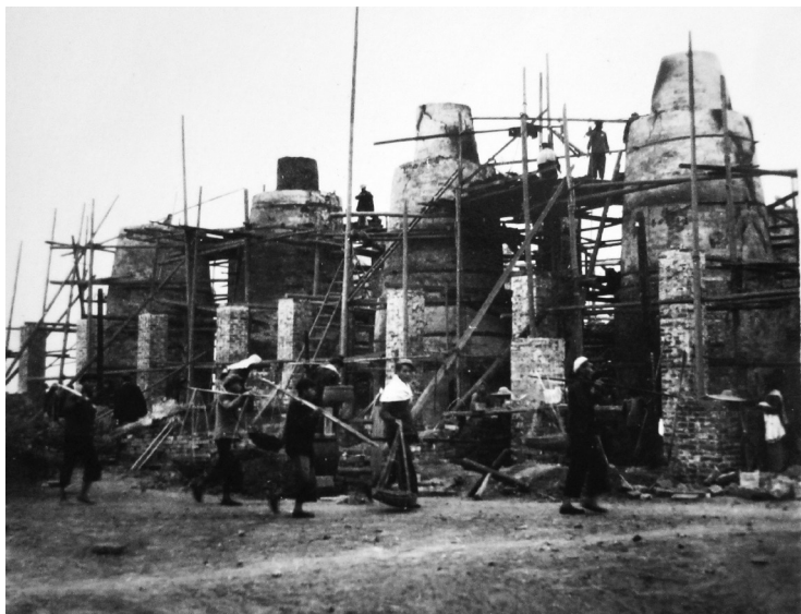
在建的濠江炼铁 高炉
