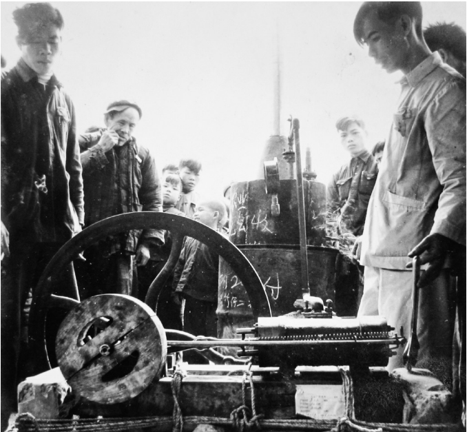
县机械厂技术员研造的 四匹马力单缸式蒸气机
