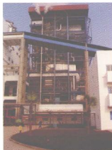
重庆开县白鹤电厂300MW锅炉钢结构
