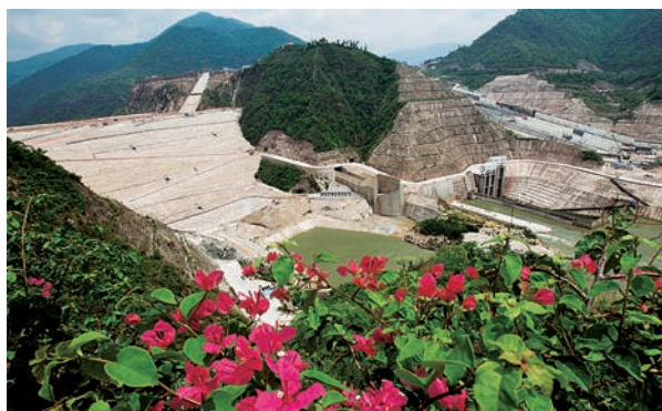
规模居亚洲第一的糯扎渡水电站拦河大坝
