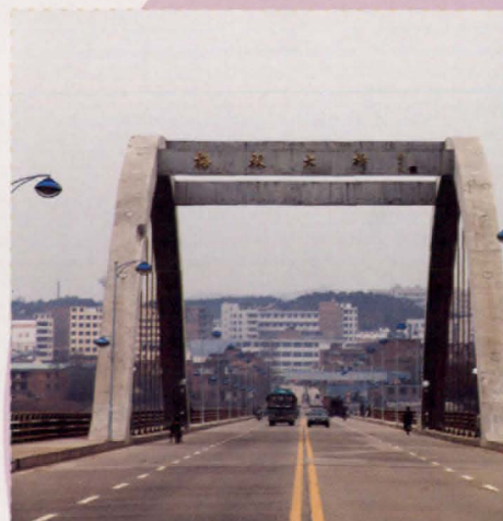
建行赣州分行贷款 支持梅林大桥建设
