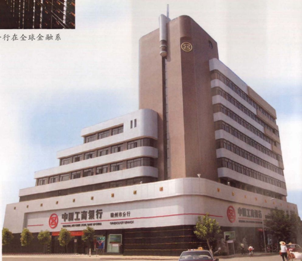
中国工商银行赣州市分行办公大楼
