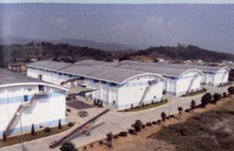
积极支持国家粮食仓储设施建设
