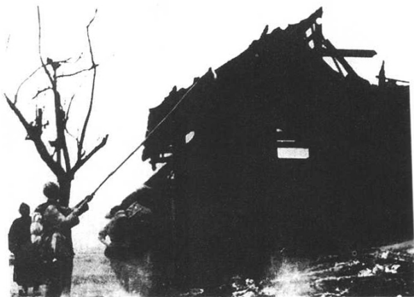
图为被匪特纵火烧坏的房子，公安部队正在帮助居民救火。
