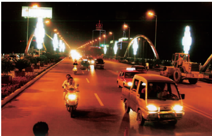
七里河大桥夜景
