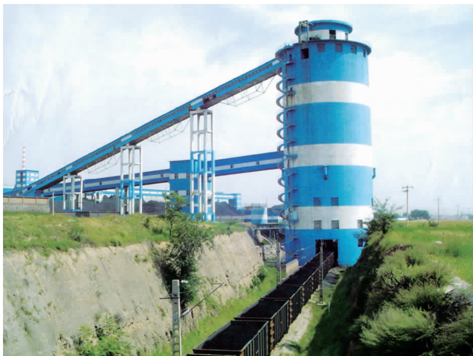
煤炭集运站皮带输送自动装车场景
