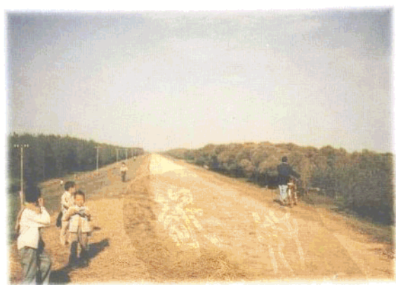
蓄洪主隔堤堤林景貌
