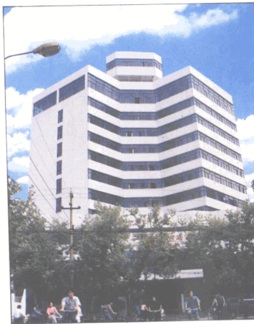
该公司承建的黄石市机电设备总公司大楼
