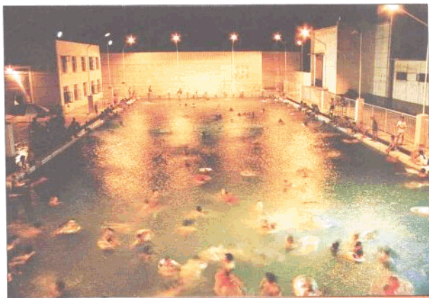
青山区白玉山游泳池工程
