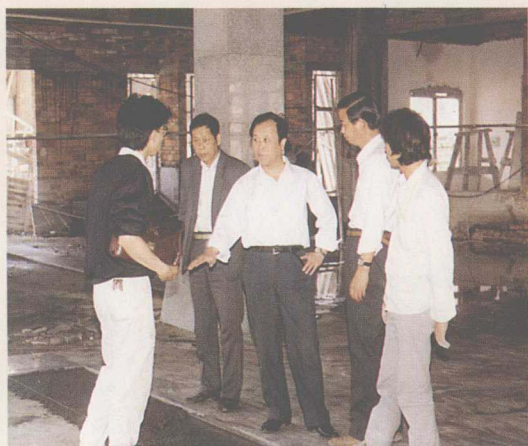
正在建设中的图书馆综合楼。
