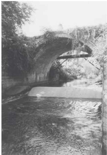
白土村宝象河上的宝龙桥，有两个大涵洞。桥头曾立造桥功德碑亭，外侧有拦马石，很精致。桥上可走农耕车马，桥下河水流淌，丰水季节可泄洪。雨季的宝象河很是壮观
