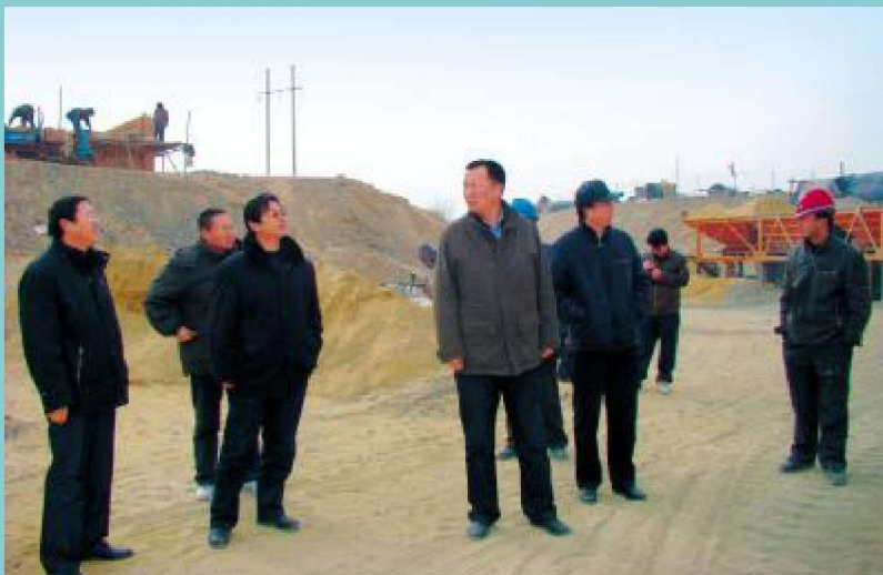
1月27日,水利厅总工程师薛塞光(前排左三)在七星渠、固海渠道砌护工程现场检查指导工作
