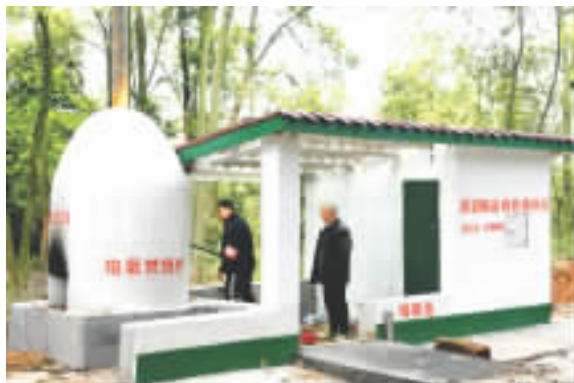
村村建起了垃圾焚烧炉。
