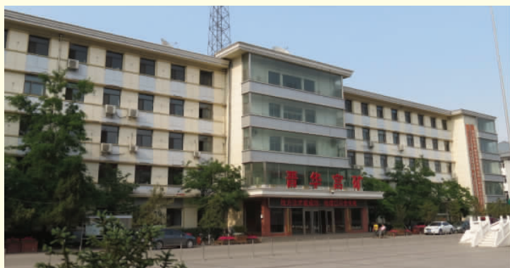
▲ 晋华宫矿办公楼
