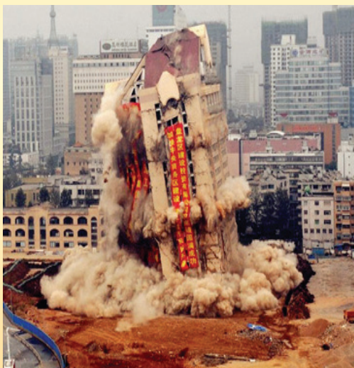
2011年12月25日，东风东路市政府原办公大楼成功爆破，“恒隆广场·昆明”将在中央商务核心区破茧而出
