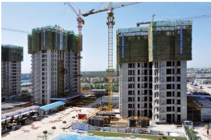
图 1-1 井然有序的施工现场
