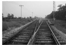
D. 在铁轨下面铺枕木
