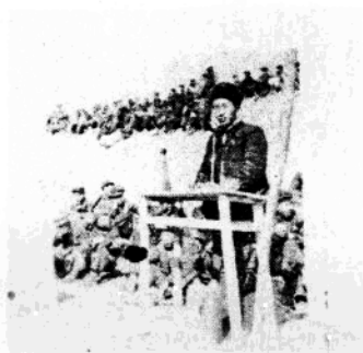
殷山水库指挥部总指挥 张力在工地进行实战动员
