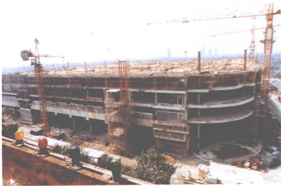
建设中的安信广场
