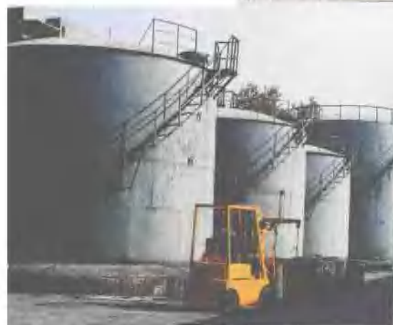
11 徐州市朝阳粮库钢板油罐
