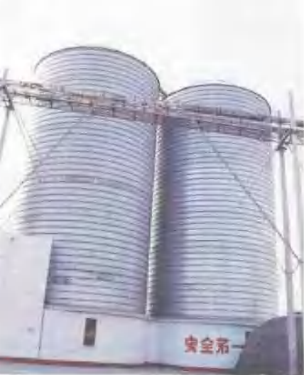
16. 铜山县米厂钢板立筒仓
