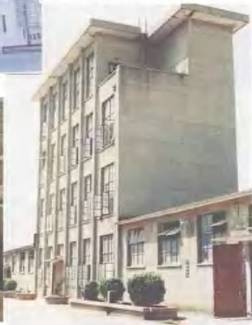
26. 徐州面粉厂配合饲料车间
