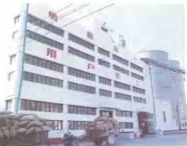
25. 铜山县米厂碾米车间
