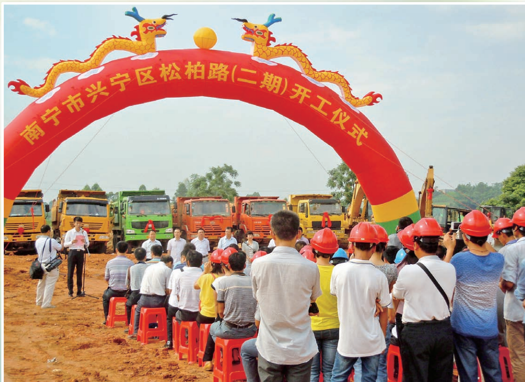
2013年5月29日，南宁市兴宁区在松柏路举行松柏路二期工程开工仪式
