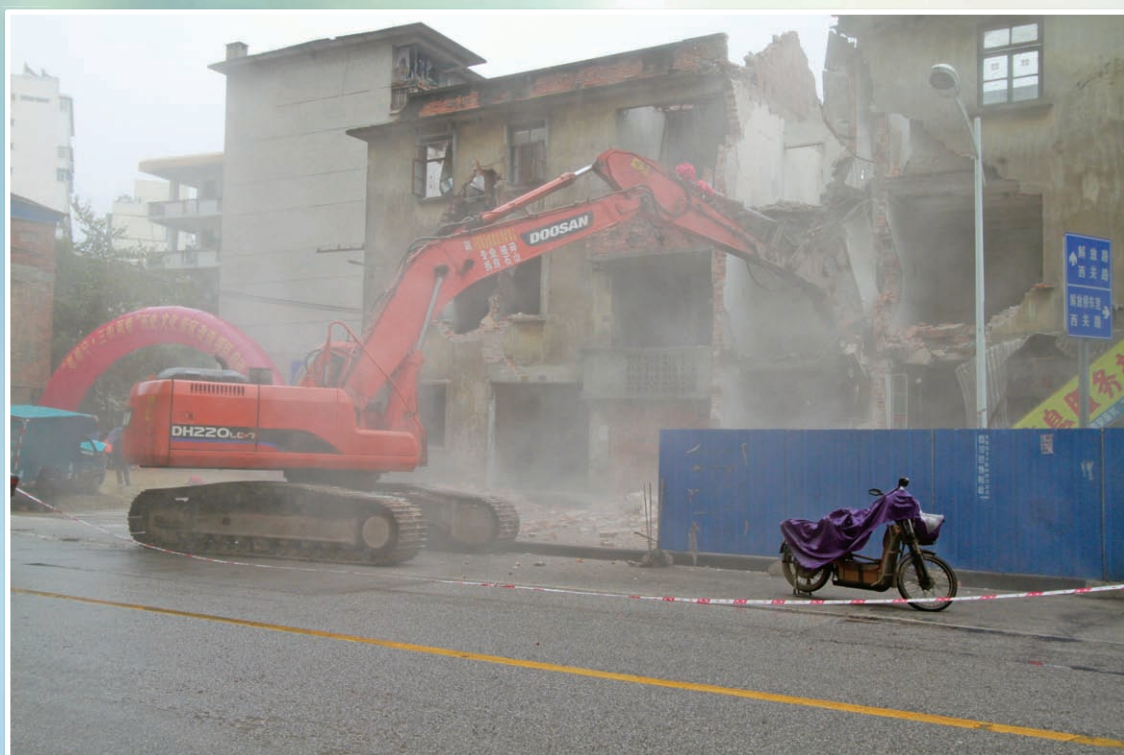
2013年1月17日，南宁市兴宁区启动“老南宁·三街两巷”历史文化街区改造项目。图为解放路迁拆现场
