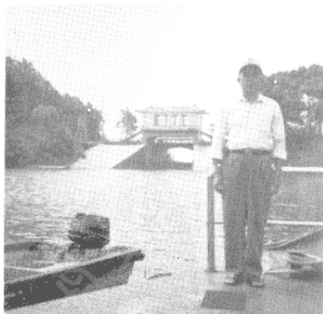
⑩图为九湾潭水库的溢洪道。
