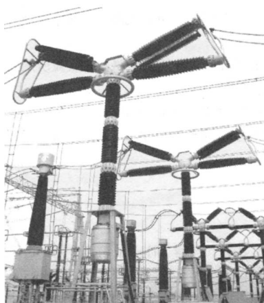
图 1-5 瓷柱式断路器 (LW10B-550)
