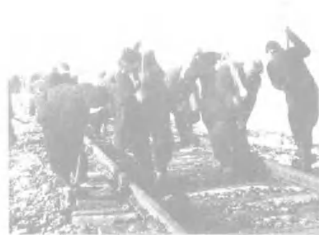
鐵路員工和沿線民工在搶修鐵路
