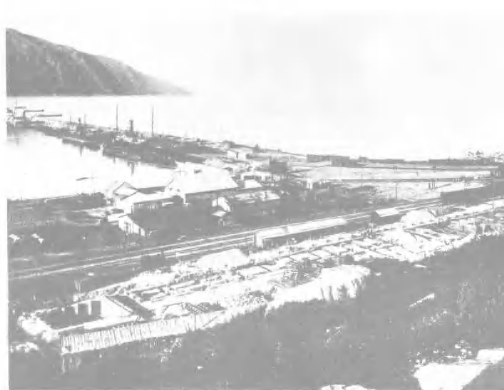
东抛海铁路在修建中
