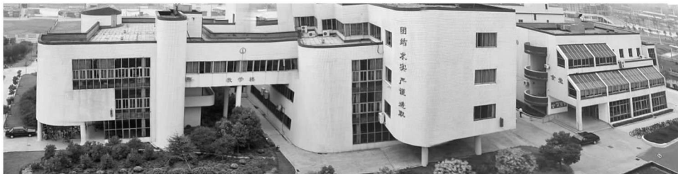
升本建院之前的主要教学楼之一。
