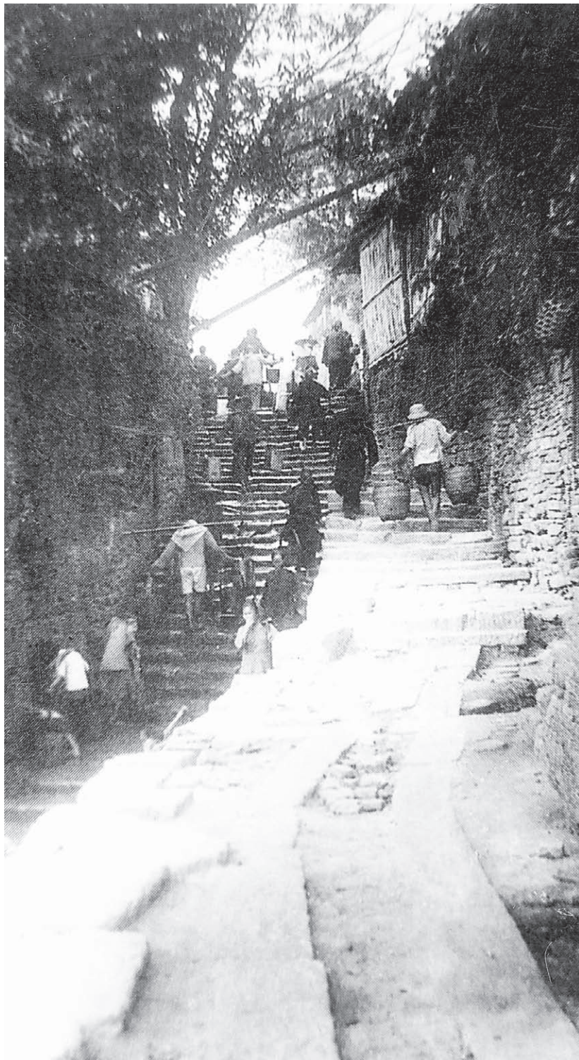
20 世纪 40 年代的南宁水闸口码头 (位于今江北大道冬泳亭处)
