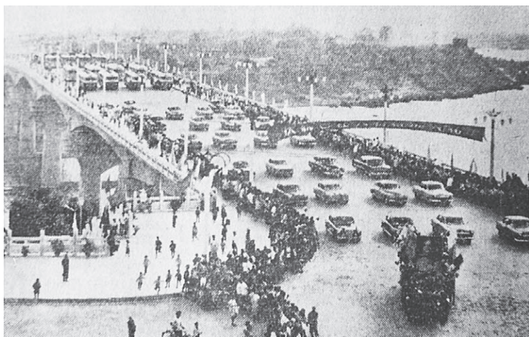
1964 年邕江大桥建成通车
