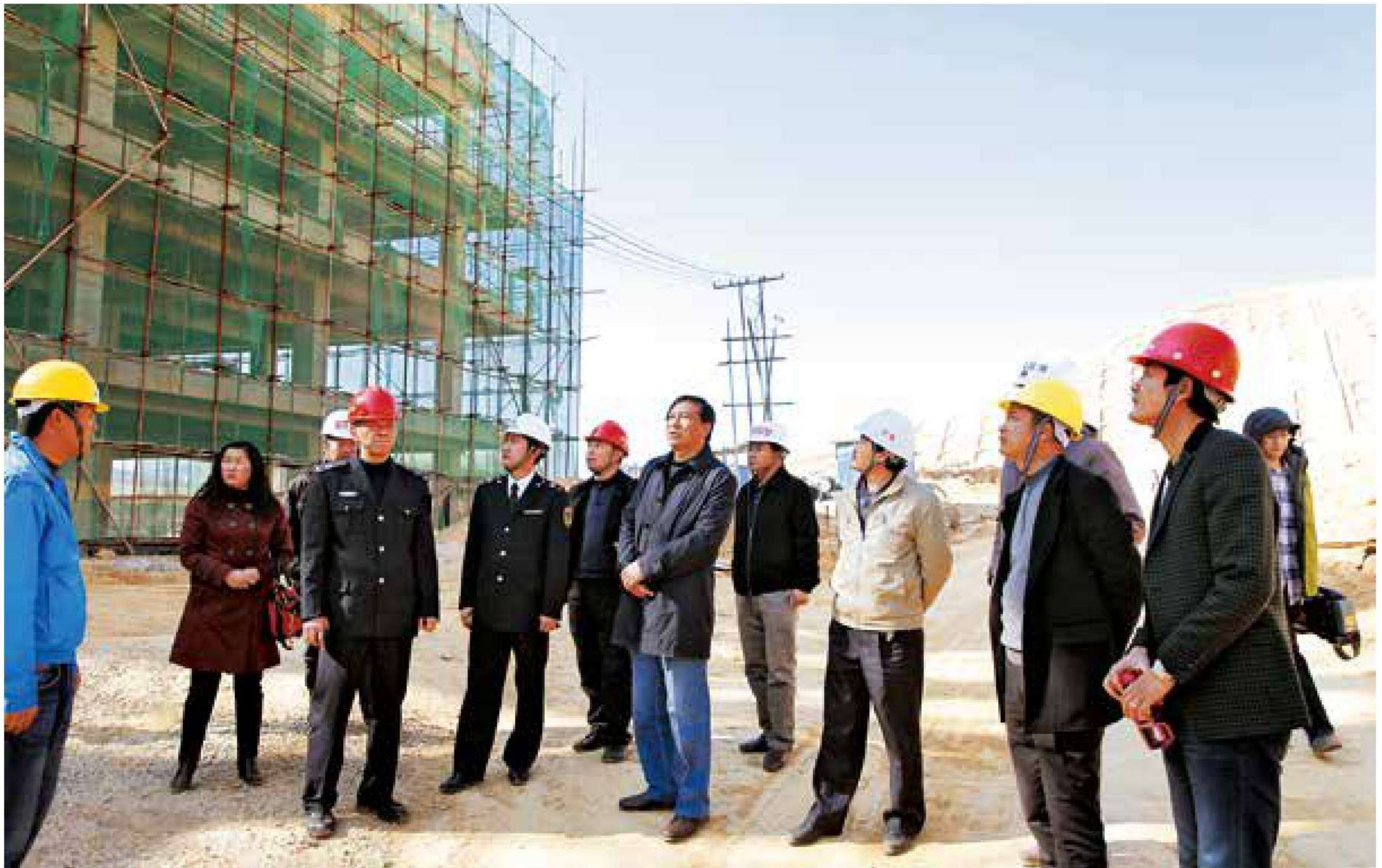
市委副书记、大理海东开发管委会常务副主任杨晓深入大理卫校项目建设现场检查指导工作。 (市委办公室 供稿)
