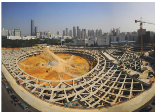
深圳市福田区下沙社区内、北侧紧邻滨河大道四层 地下室基坑开挖,构筑巨大的环形内支撑
