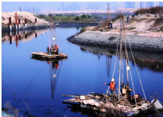
整治改造河道勘察进行水上钻探作业
