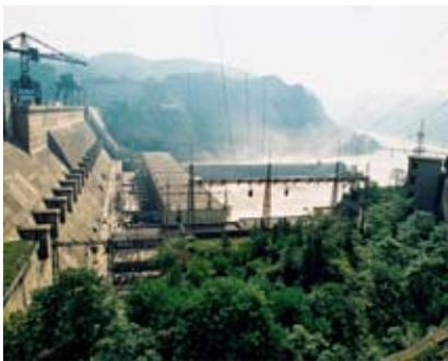
上：三门峡大坝高106米，长875米，是黄河干流上的第一座大型水利工程。
