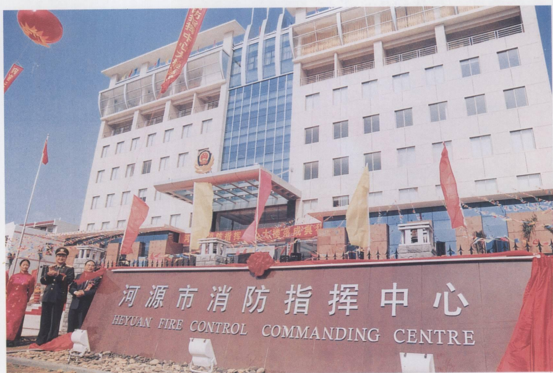
2003年11月27日，河源市公安消防局指挥中心大楼落成。
