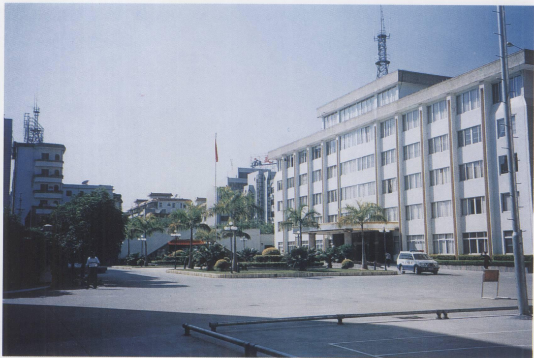
1991年1月3日，市公安局办公大楼建成投入使用。
