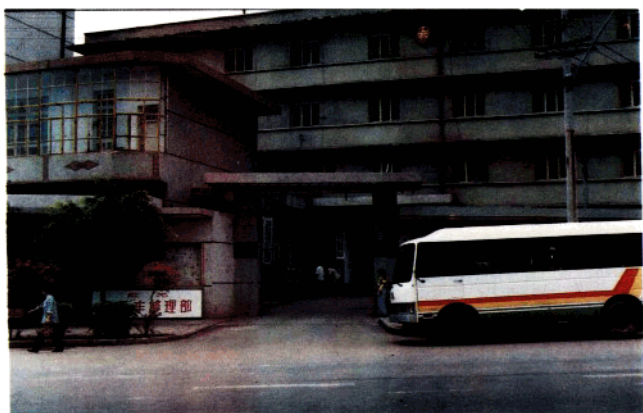
①凉山州工商局办公楼正面
