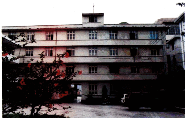
②凉山州工商局办公楼背面
