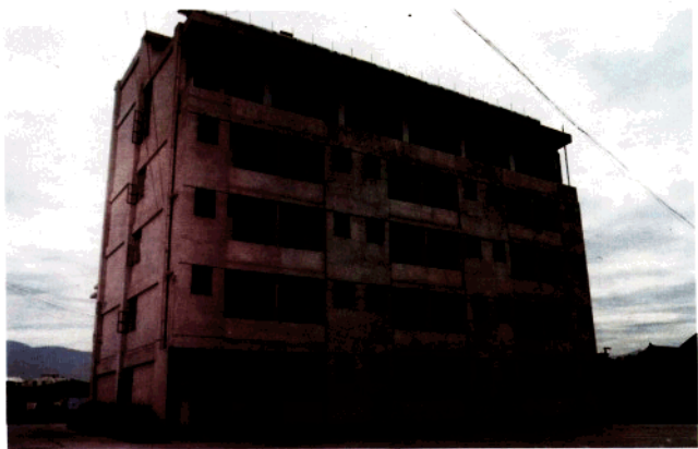
③凉山州工商局干部培训中心大楼
