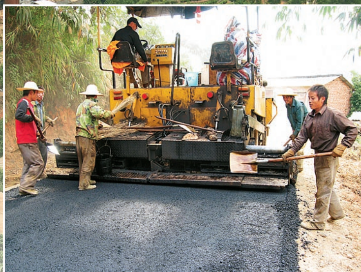
正在摊铺的沥青路面
