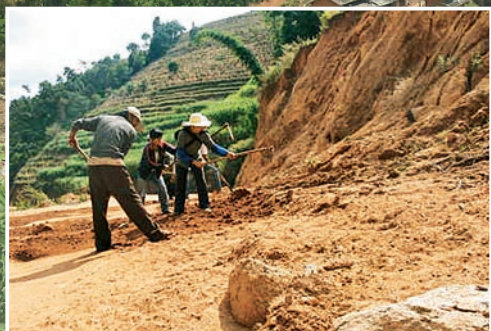
博尚镇修筑村社道路
