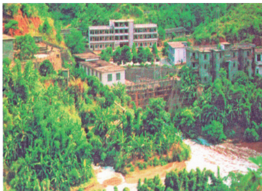
1960年7月12日，大湾水力发电站第一台机组(180千瓦)试机发电成功，基本上改变了岑溪无电力工业的时代
